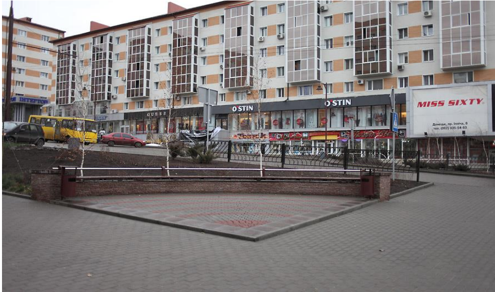
ПРОСПЕКТ ІЛЛІЧА М. ДОНЕЦЬК- РЕКОНСТРУКЦІЯ І КОМПЛЕКСНИЙ БЛАГОУСТРІЙ
