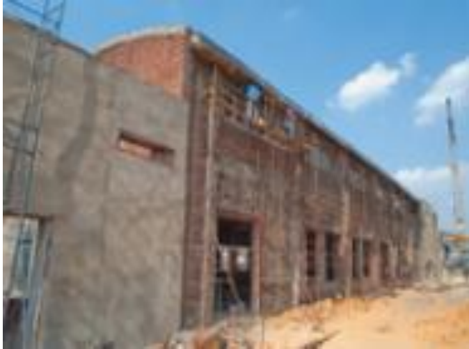
БУДІВНИЦТВО ХІМВОДООЧИСТКИ КОГЕНЕРАЦІЙНОЇ УСТАНОВКИ ГОРЛІВСЬКОГО КЗХ (М. ГОРЛІВКА ДОНЕЦЬКОЇ ОБЛАСТІ)
